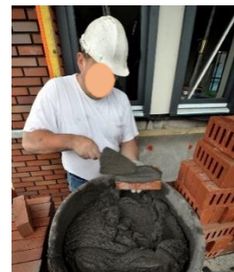
Afbeelding 2.2 - Deze metselaar neemt geen maatregelen tegen blootstelling aan cementspecie.
