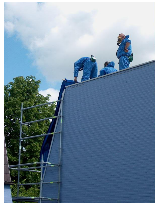
Afbeelding 3.2 - Wat is het risico ook alweer bij asbest verwijderen?
