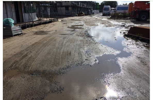
Repac als bouwweg – herfst / winter - bagger
