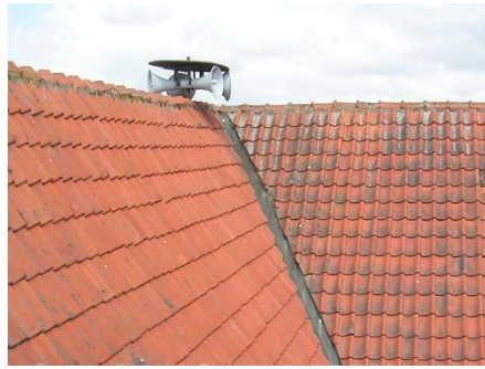
Afbeelding 2.4 - Links een voorbeeld van een kilgoot waarvoor dakpannen op maat gemaakt moeten worden. Rechts de dakpanknipper.
