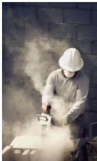
Afbeelding 7.2 - Blootstelling aan kwartsstof, zowel direct (links) als indirect (rechts). Foto links overgenomen van TNO, stofvrijwerken.tno.nl.
