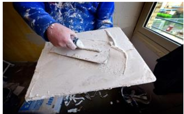
Afbeelding 9.4 - Een stukadoor aan het werk.
